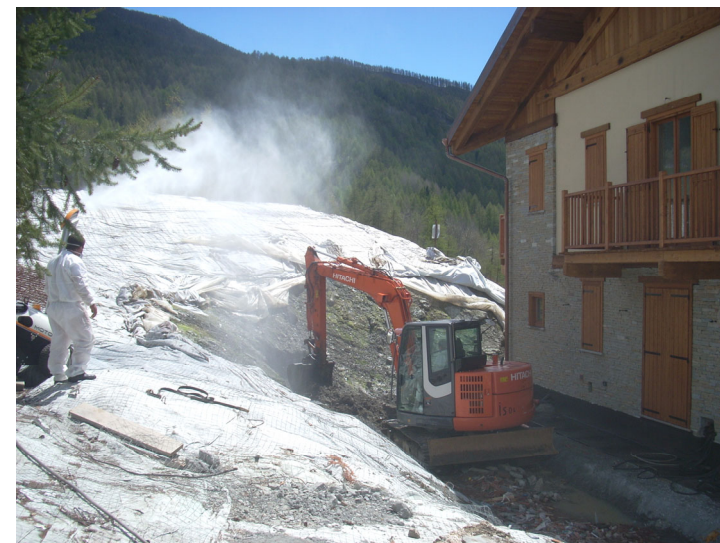
Gestione terre e rocce da scavo con amianto. Jovenceaux (TO)
