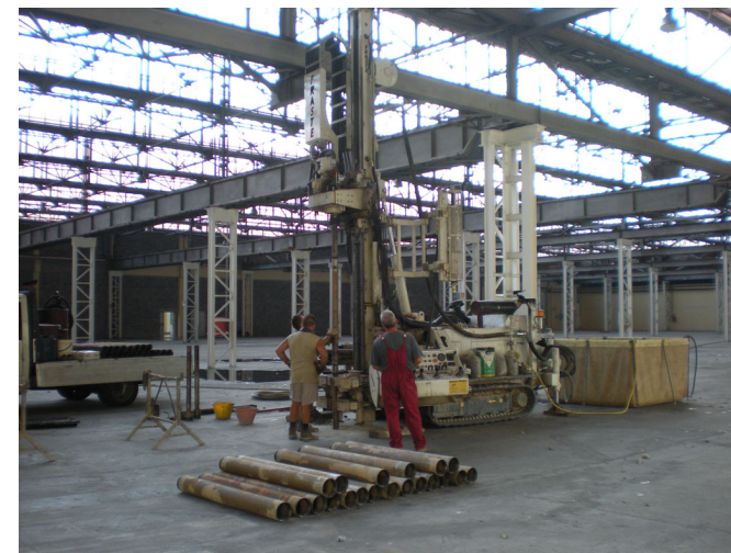
Caratterizzazione ex stabilimento Diatto. via Frejus, Torino
