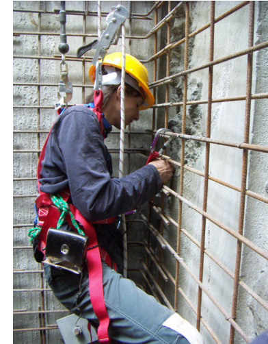
Rilievi geologici e geomeccanici, Ascensore del Forte di Exilles (TO)
